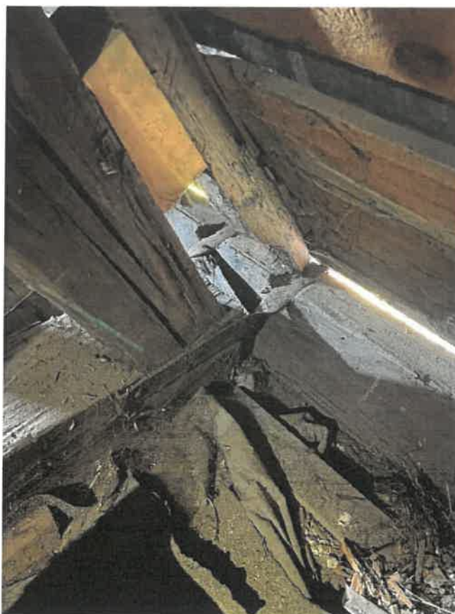
Zdjęcie 24. Widok połączenia łącznikiem stalowym murlaty z belką główną dolną.
