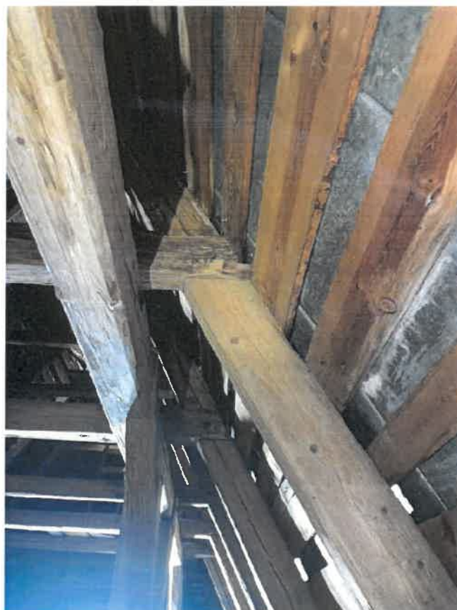
Zdjęcie 23. Widok wysuniętej ze złącza ciesielskiego jętki.
