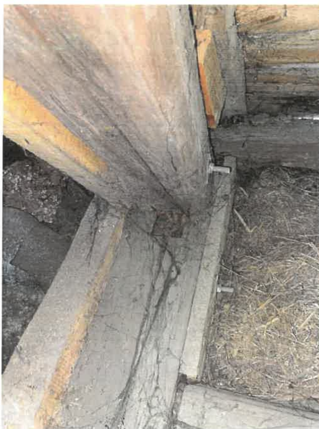
Zdjęcie 21. Widok wysuniętej ze złącza ciesielskiego krokwi.
